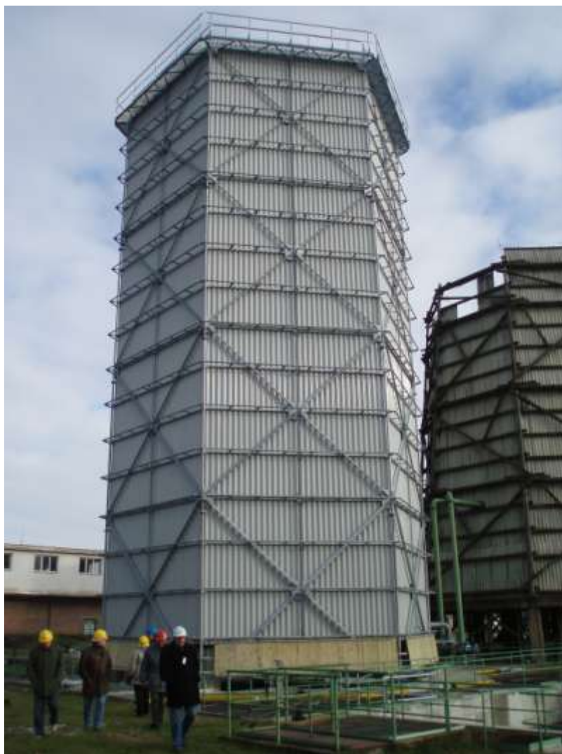
Dokončená chladicí věž - prosinec 2007
