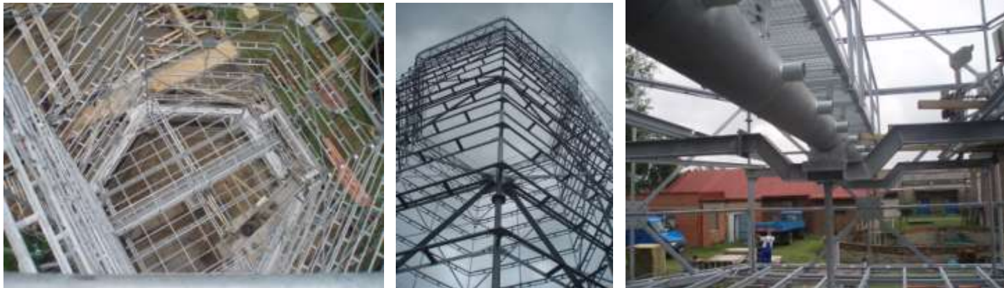
Montáž ocelové konstrukce - červenec 2007
