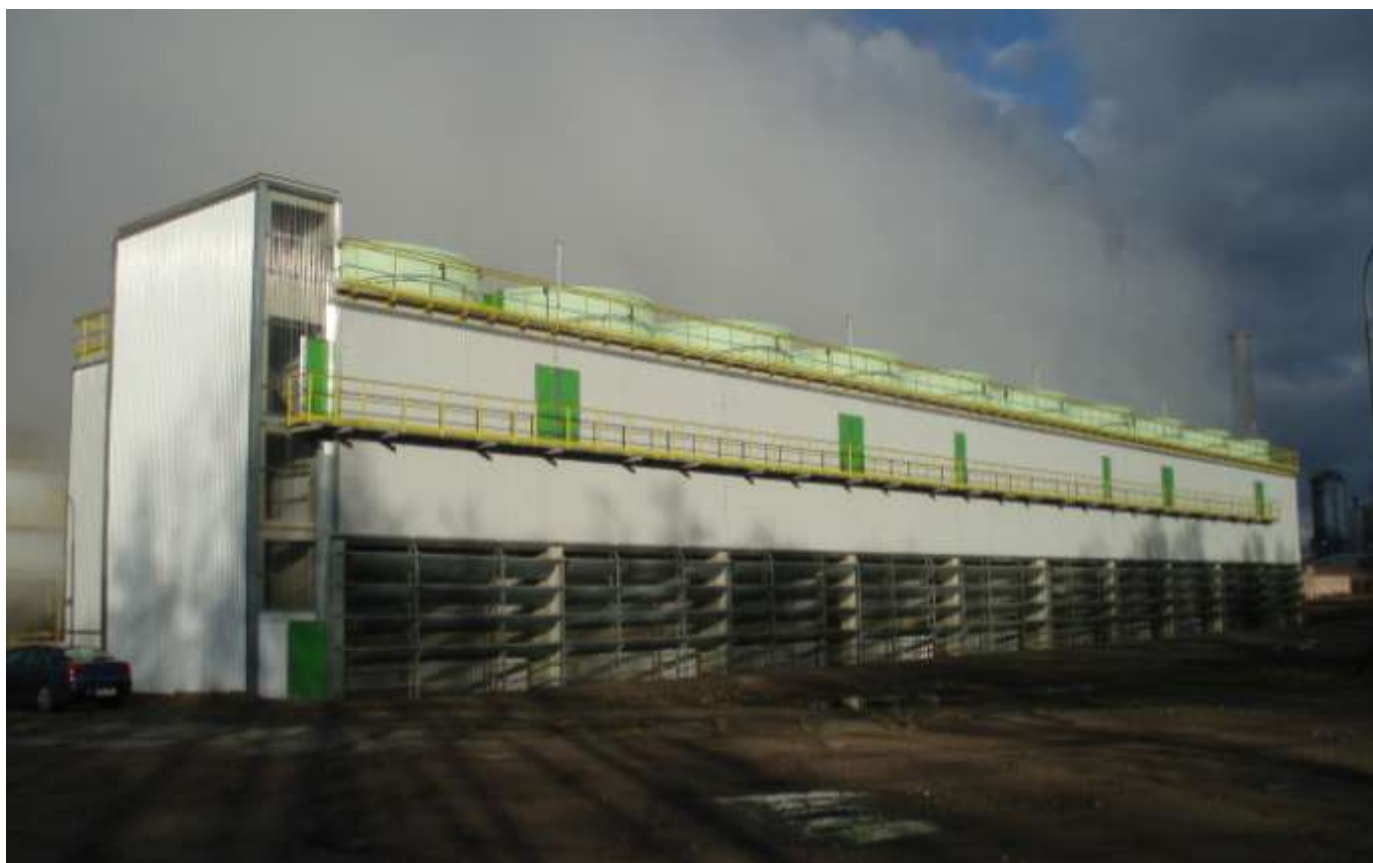
Dokončená CHV č. 4 po opravě
