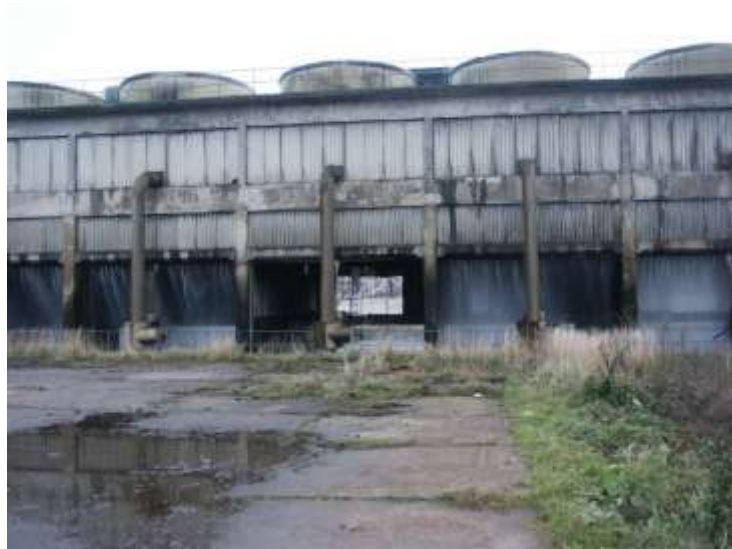
Chladicí věž před opravou - leden 2007
